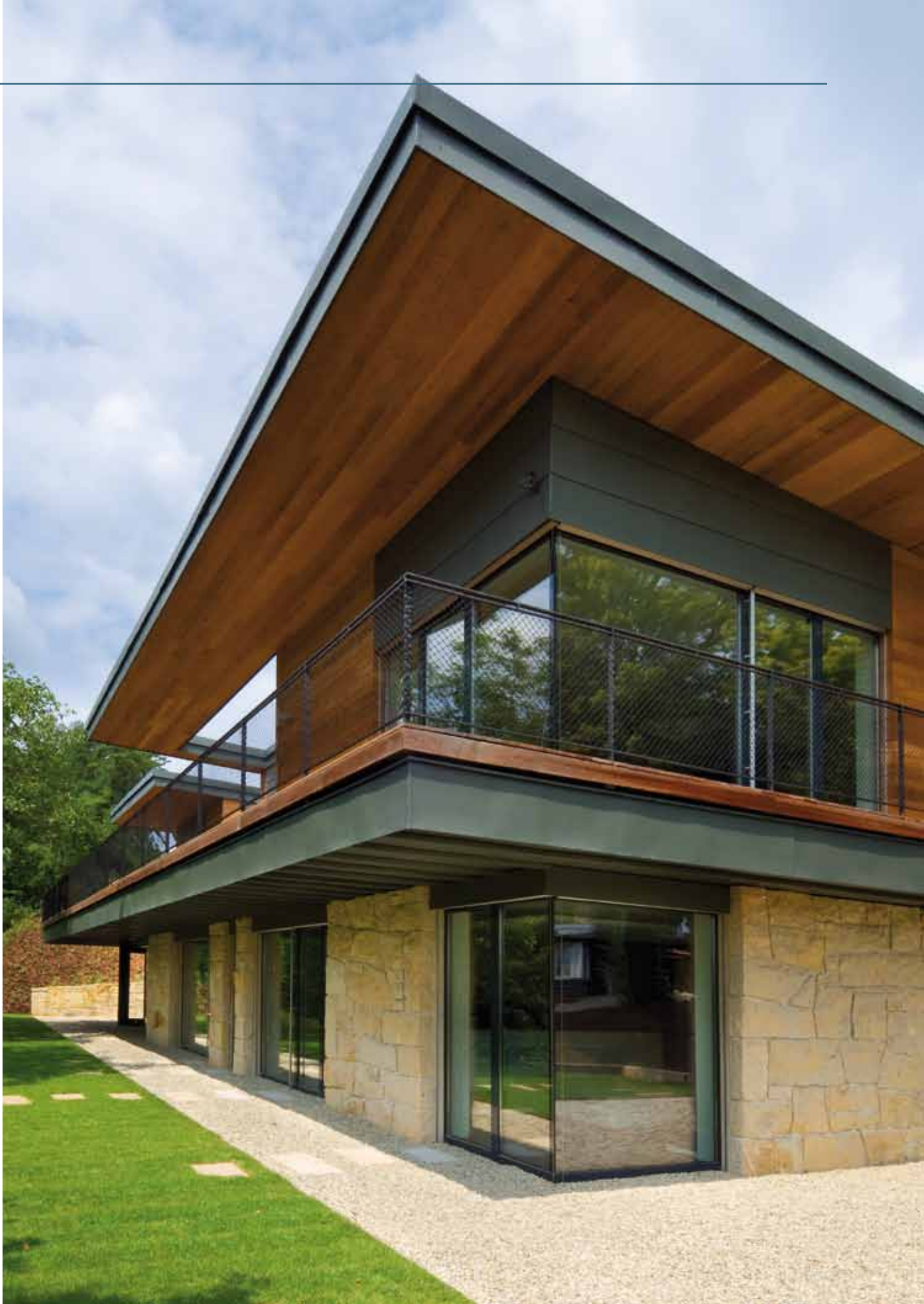
Železobetonová konstrukce je obložena třemi materiály – pískovcem, exotickým cedrem a títanzinkem se speciální povrchovou úpravou. Ten je použit i na pultovou střechu objektu. Výrazným prvkem jsou také velká francouzská okna, umožňující průchod na zahradu a v horním podlaží na terasu.
