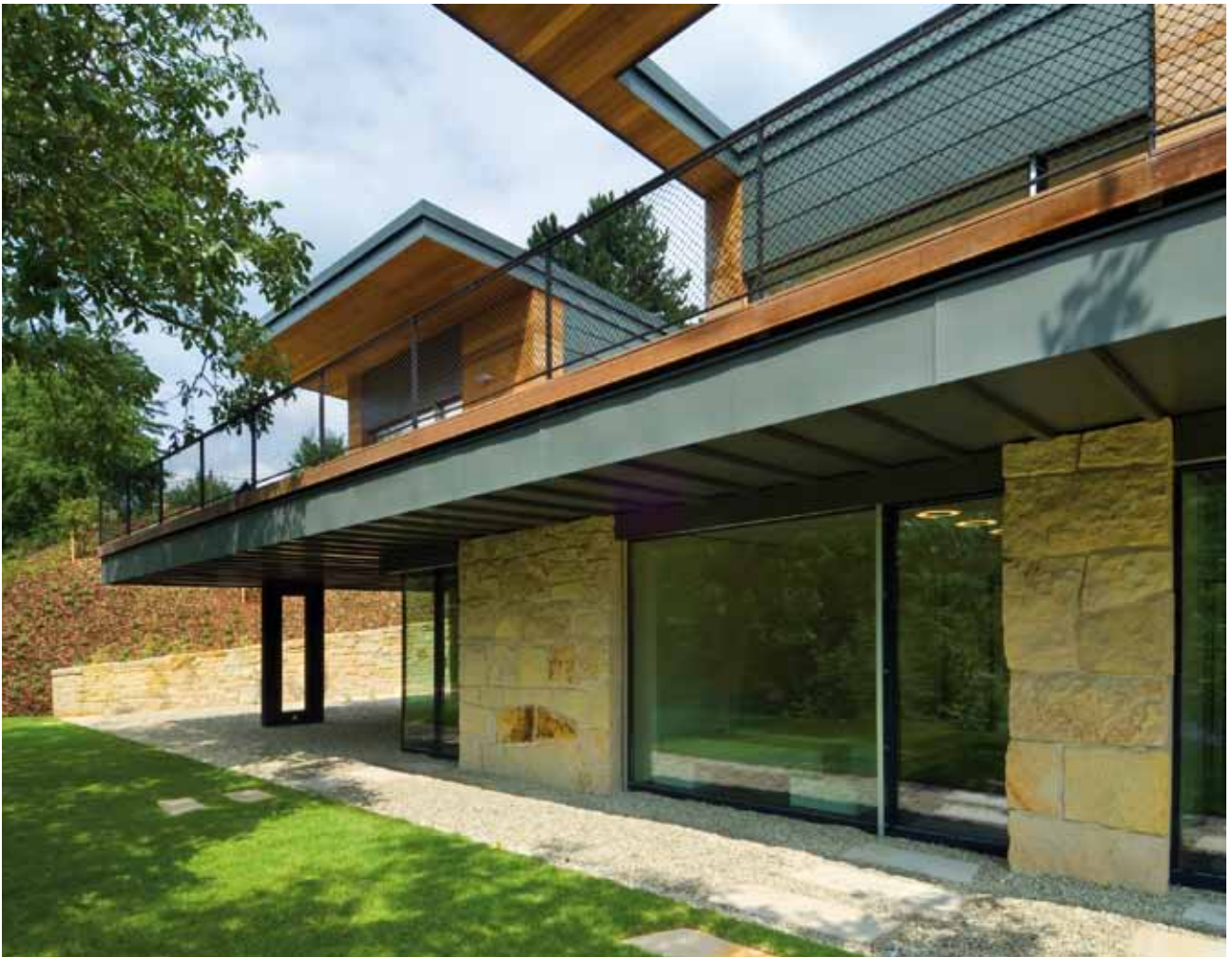
Střecha i terasa na jižním průčelí mají velké přesahy kvůli přístínění a snížení tepelných zisků. Terasa je z masaranduba, tropického dřeva, které skvěle odolává náročným klimatickým podmínkám s rozdílem teplot až 50 °C.
